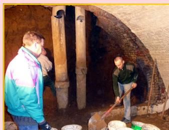
Le bombardement de 1914 avait détruit toute la partie arrière de la traverse-abris et notamment le puits où venait se loger l'escalier. Le projet a donc commencé par un important travail de déblaiement et d'évacuation des terres par le chantier d'insertion.
