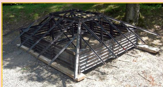
**L**e premier lanterneau réalisé par les élèves du lycée technique de Valenciennes est arrivé sur le site. Une fois muni des surfaces vitrées, il sera installé sur la cheminée surplombant le magasin à poudre.
